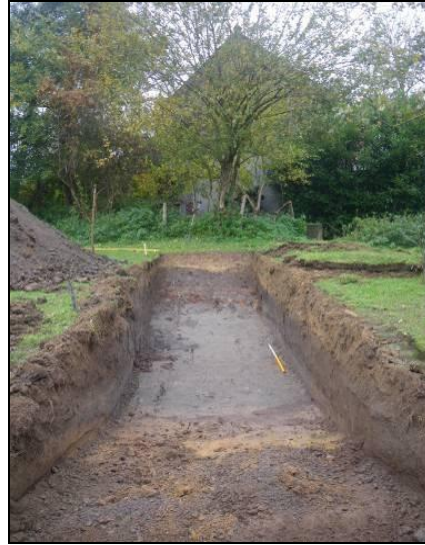
Figuur 2.6b: Profielopbouw in proefsleuf De opgebrachte zandige bovengrond en de met puinrijk materiaal opgevulde oude kleiige bedding bij de molenkolk.
