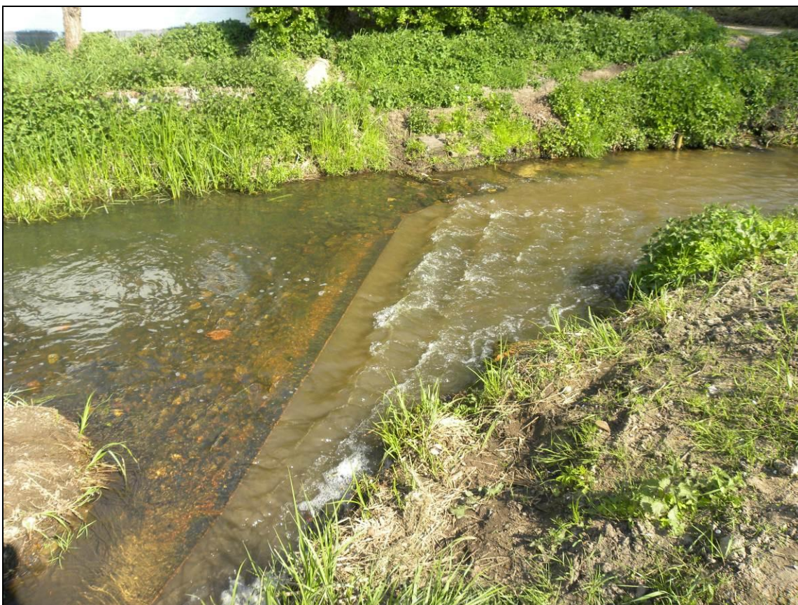
Lokstroomversterker leidt de (vertroebelde) lokstroom uit de TMZ onder de hoofdstroom door naar tegenoverliggende oever.
