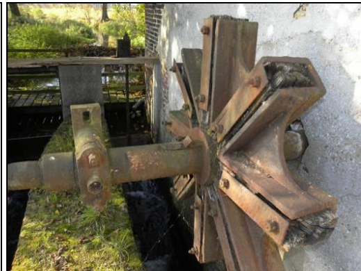
Figuur 2.7b: Restanten stuwwerk en waterrad
