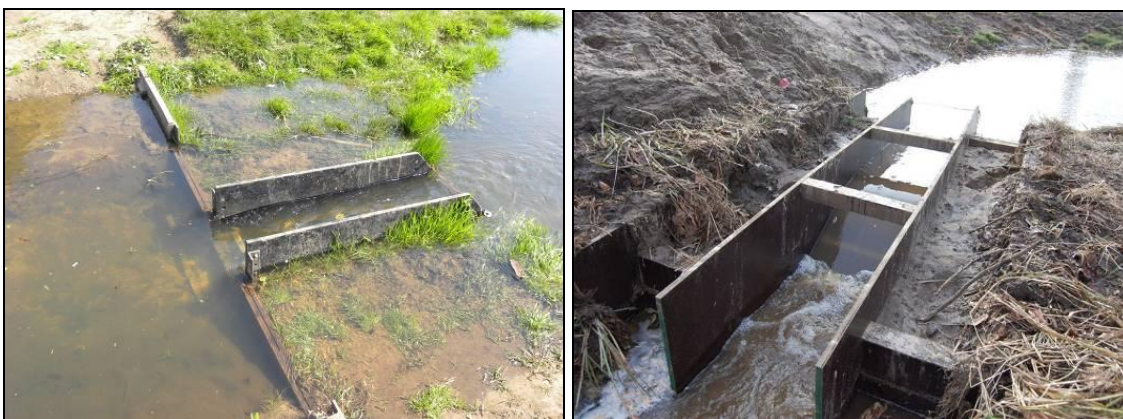
Figuur 3.5: Inlaatwerk bovenstrooms
