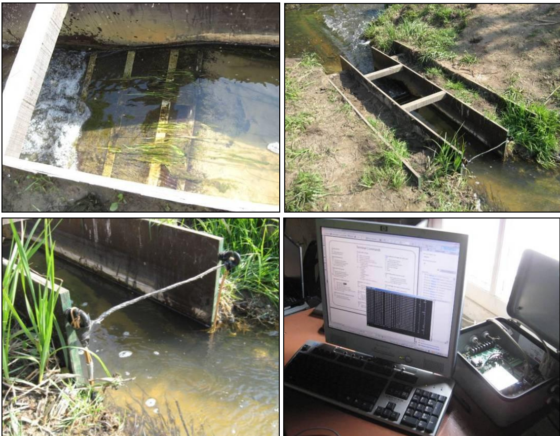
Figuur 6.6. Vernauwde dwarsdoorsnede (linksboven), met fish counter (rechts boven), Vast PIT-detectie-station (links onder), ontvangers en dataloggers in de molen (rechtsonder).
