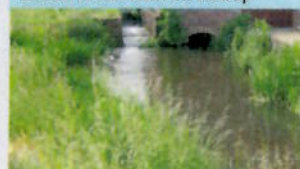
Sectie 2: kom stroomafwaarts van de Luijensmolen
